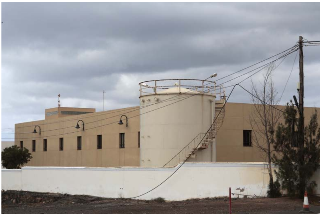
Depósito de agua de Canal Gestión. Foto: Juan Mateos.
