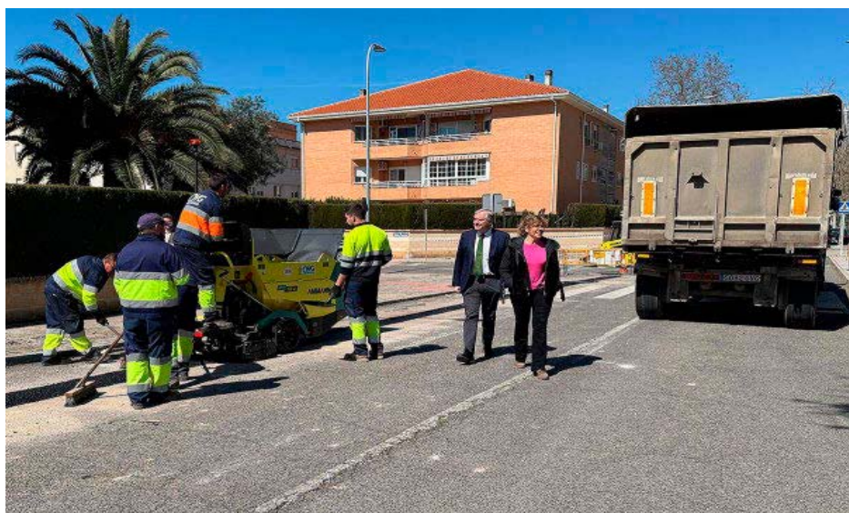
Cañizares y Torres visitaron ayer las obras que se están ejecutando en la calle José María de la Fuente. / LT
